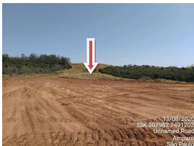
Foto 1 – Área vistoriada para a instalação da EMA. (Data: 13/08/2020).
