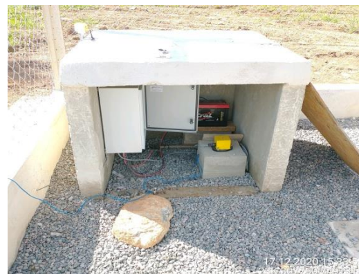
Foto 6 – Interior da caixa de concreto para proteção. (Data: 17/12/2020).
