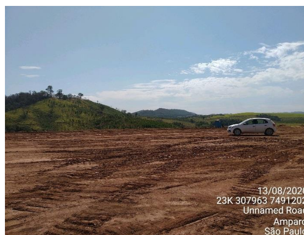
Foto 2 – Área vistoriada onde já foi realizada a terraplanagem. (Data: 13/08/2020).
