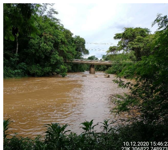
Foto 4 – Vista geral da área prevista para instalação do PHJ. (Data: 10/12/2020).
