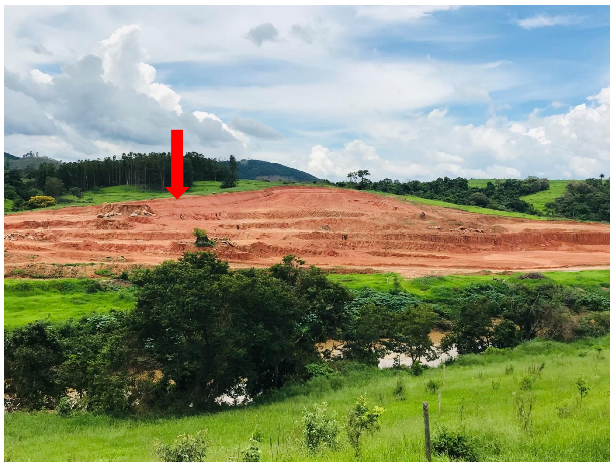
Foto 1 – Área de terraplenagem na margem esquerda, antiga localização do PA-01.
