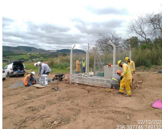
Foto 4 – Estrutura do cercamento para a Estação Sismográfica. (Data: 02/12/2020).
