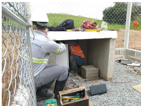
Foto 3 – Instalação dos equipamentos dentro do abrigo, caixa de concreto. (Data: 02/12/2020).
